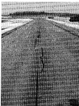
図4.1 縦断クラックの例
