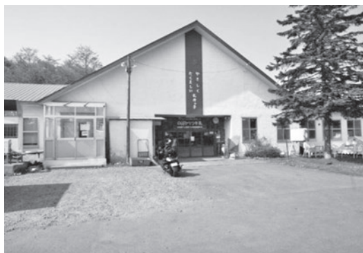
旧生徒玄関が店舗になっている。
