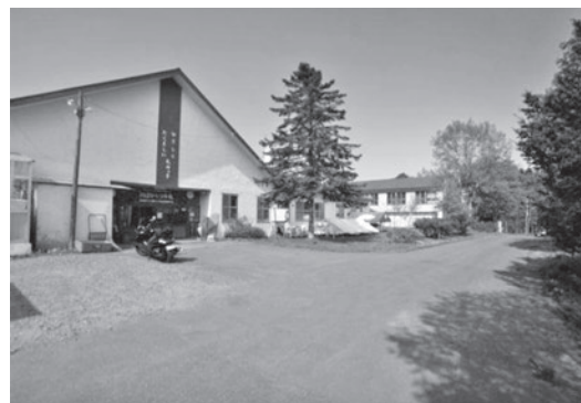
奥に見える2階建が体育館。右手にグラウンドがある。
