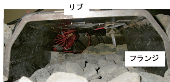
図-1 鉄まくらぎの断面
