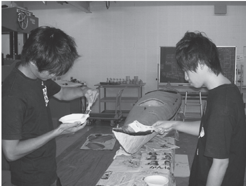
写真-15 デッキ第1層WR-LPU塗布
