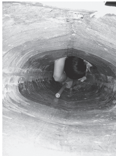
写真-12 ハル〜デッキの継目内貼り
