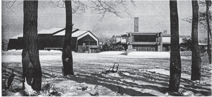
図4 北海学園大学図書館 同体育館の遠景
