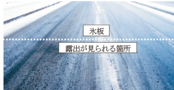
写真-6 氷板路面の路面露出状況
