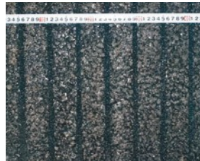
写真-2 G-Pの舗装表面
