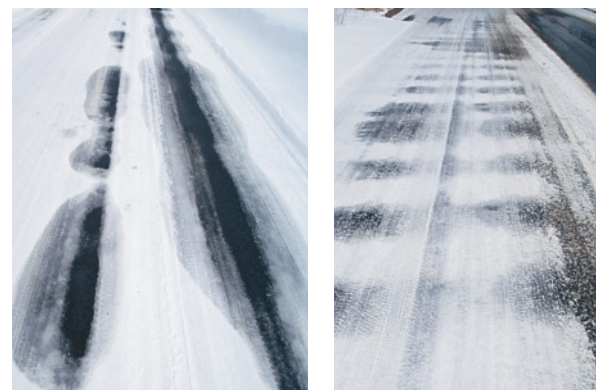
写真-7 圧雪路面露出状況 (左: 縦断露出 右: 横断露出)
