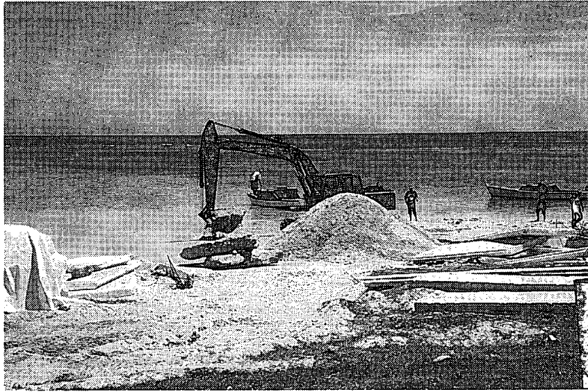
写真11 建設中の埠頭
