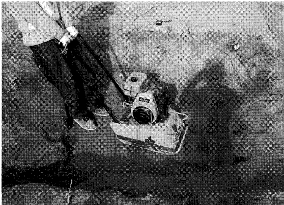
図14 締め固めコンパクター
